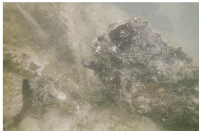
Grosse Blöcke unterhalb der Uferbefestigung
