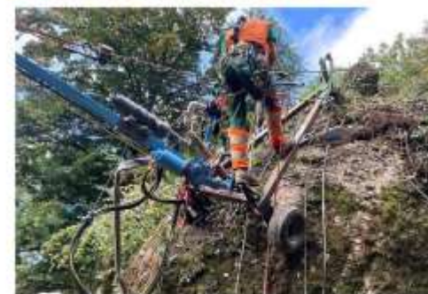
Les tiges métalliques permettent d'ancrer les masses instables de poudingue.
