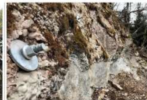
Les travaux consistent aussi à stabiliser les blocs grâce à des sous-remplages en béton.
