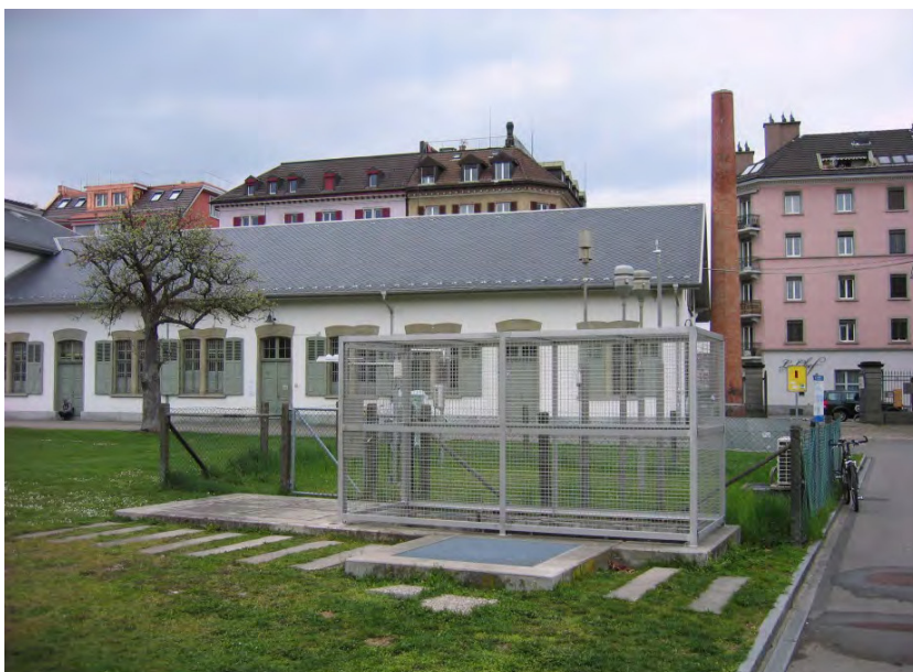
Abb. 2-45: Messstation Zürich (Messstation unterirdisch)
