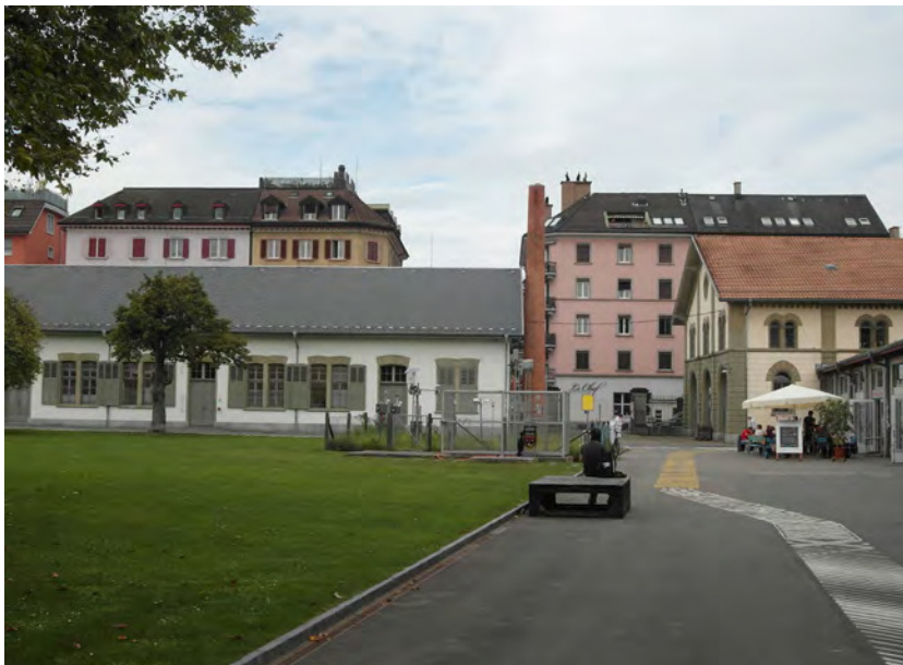
Abb. 2-44: Messstation Zürich, Zeughaushof
