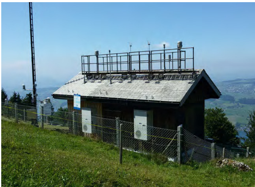
Abb. 2-36: Messstation Rigi mit neuem Dachaufbau (2015)
