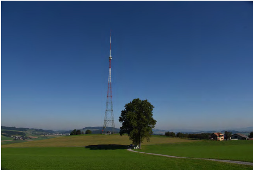
Abb. 2-7: Messstation Beromünster, stillgelegter Sendemast des ehemaligen Landessenders
