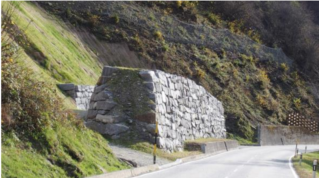
Fig. 4.6: Embankment Botegeh, Canton Grisons, 2015 (Photo: Tiefbauamt Graubünden)
