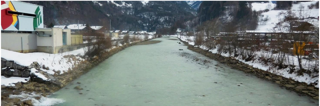
Abb. 35: Der Versuchsstandort in der Schwallstrecke der Hasliaare für die Versuchsreihe 2018.
