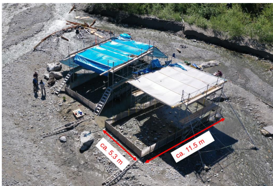
Abb. 4: Flugaufnahme der beiden Versuchsanlagen
