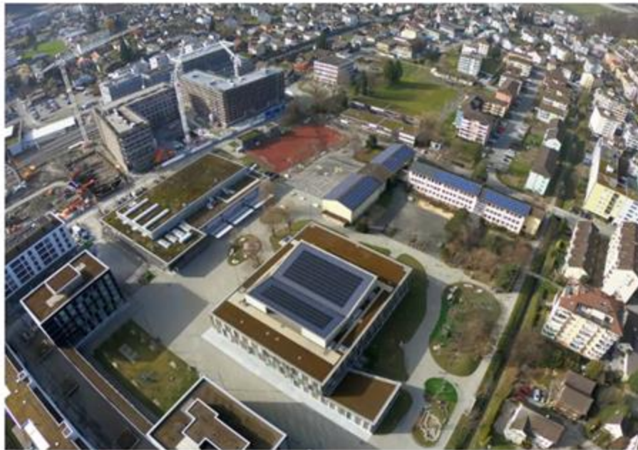
Prise de vue par drone, site de l'école Zentrum/Allmend à Horw (LU)
