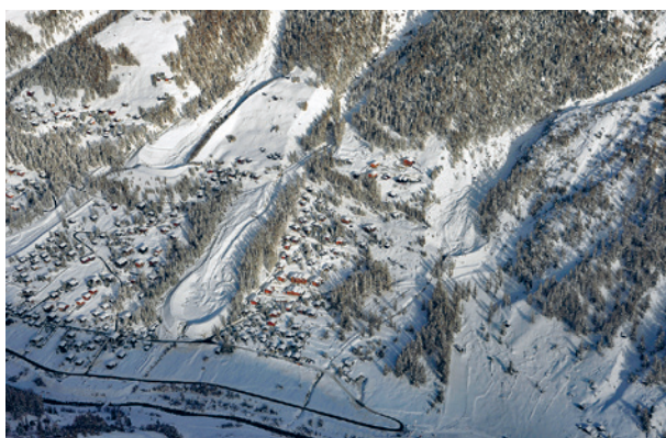
Fig. 126: À Zinal, des avalanches ont été observées dans trois parcours équipés de digues de retenue. Les avalanches se sont arrêtées juste au pied des digues (photo: P. Stoeber, 10.01.2018).
