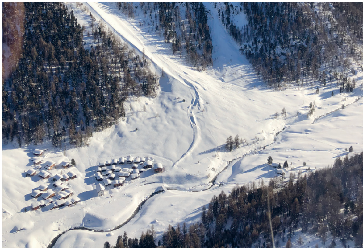
Fig. 88: Près de Meiden, un bras de l'avalanche a contourné l'extrémité inférieure de la digue de déviation, et s'est arrêté à seulement 20 m du hameau (photo: Rinaldo Hugo, 29.01.2018).
