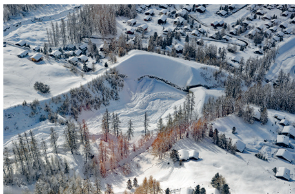
Fig. 127: La digue d'avalanche du torrent du Perrec à Zinal, dans le Valais, a vu l'avalanche s'arrêter juste à son pied. Il n'est pas possible de juger l'efficacité ou le dimensionnement de la digue (photo: P. Stoeber, 10.01.2018).
