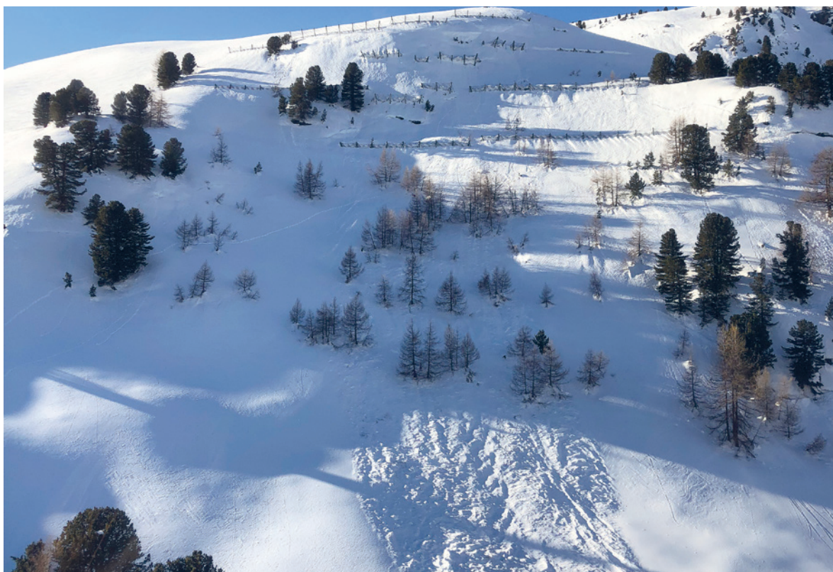
Fig. 89: Une avalanche s'est déclenchée dans les filets à neige au-dessus de Meiden, en dessous de la ligne supérieure de l'ouvrage et a traversé l'ensemble de l'ouvrage. L'avalanche s'est écoulée dans la jeune forêt en dessous de l'ouvrage, sans provoquer de dommages (photo: Rinaldo Hugo, 29.01.2018).
