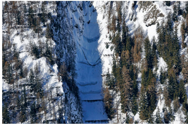
Fig. 137: Des claies à neige et des barrières contre les chutes de pierres ont été construites dans le parcours d'avalanches Wandschluichen dans le Lötschental (VS). En janvier 2018, quelques barrières contre les chutes de pierres ont été endommagées par des avalanches et par la pression de la neige. Des dommages similaires étaient déjà survenus au cours d'hivers précédents (photo: SLF/S. Margreth, 24.01.2018).
