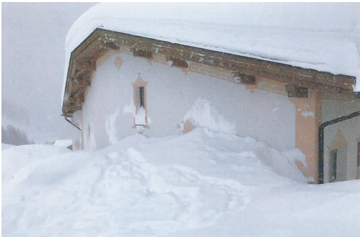
Fig. 103: Dépôts épais d'avalanches devant la maison située le plus à l'est parmi les bâtiments touchés (photo: Fam. Moser-Jenal).
