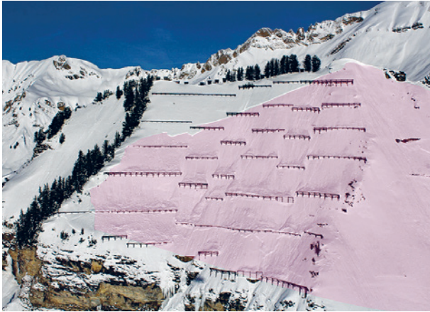
Fig. 110: Ouvrage de retenue d'Urseren, Brien (BE), dans lequel une avalanche de plaque de grande surface s'est déclenchée lors de l'épisode avalancheux des 21 et 22 janvier 2018. La hauteur de rupture a dû atteindre environ 50 cm. L'avalanche n'a pas provoqué de dommages (photo: U. Ryter, 24.01.2018).
