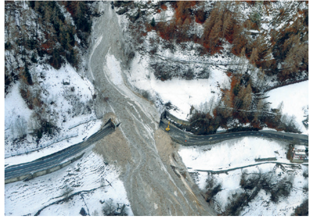
Fig. 133: Près d'Eisten, Saastal (VS) l'avalanche Putzloiwna a enseveli les deux entrées de la galerie en janvier 2018 (photo: P. Stoebener, 10.01.2018).
