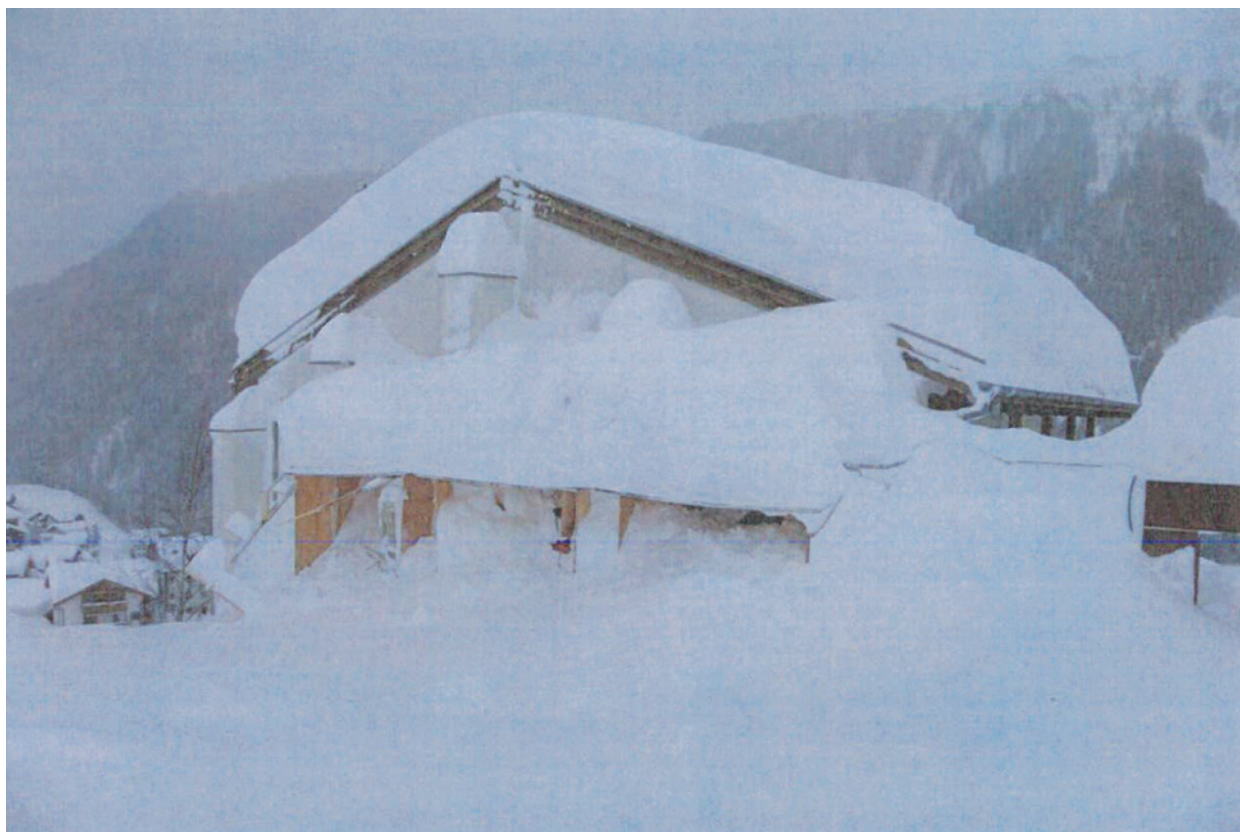
Fig. 102: Vue du bâtiment situé le plus haut, touché par l'avalanche (photo: Fam. Moser-Jenal).
