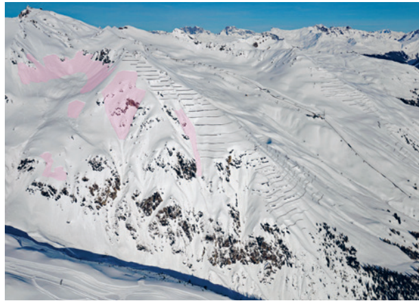
Fig. 111: Ouvrage de retenue de Schiahorn, Davos (GR), à côté duquel quelques grandes avalanches (taille 4) se sont déclenchées pour s'écouler vers le Schiatobel. Aucun départ d'avalanche n'a été constaté dans l'ouvrage même (photo: M. Phillips, 24.01.2018).
