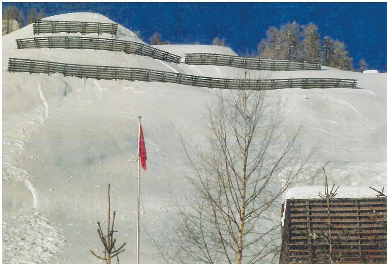
Fig. 101: Vue de la zone de départ de l'avalanche près de Samnaun Laret le 23.01.2018 (photo: AWN GR)
