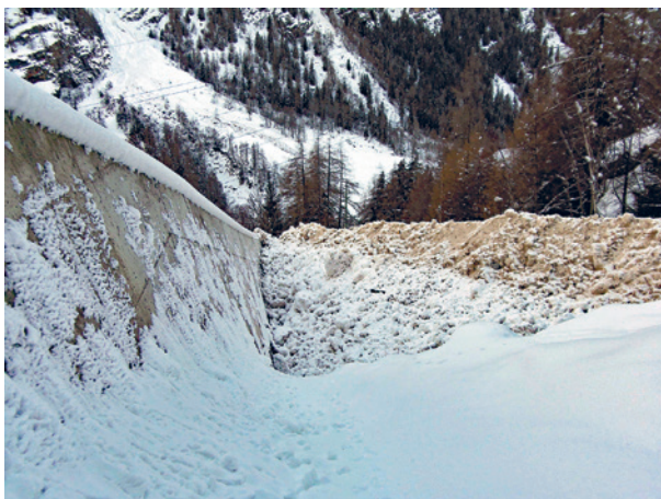
Fig. 131: Dans le parcours de Biel près de Saint-Nicolas (VS), le mur de déviation sur un cône de déjection surélevé en 2016 a été rempli jusqu'en haut par les dépôts d'avalanches. La hauteur de ce mur de déviation varie entre 5 et 10 m. Un départ supplémentaire aurait pu menacer le pylône en charpente métallique d'une ligne à haute tension et des habitations. Par la suite, les dépôts d'avalanches ont été évacués mécaniquement (photo: Geoformer, 05.01.2018).
