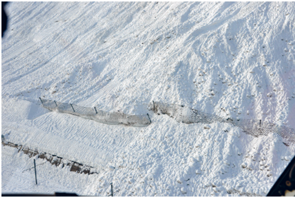
Fig. 136: L'avalanche de Schafgraben à l'entrée de Zermatt (VS) est descendue plusieurs fois en janvier 2018, et a endommagé des barrières contre les chutes de pierres, construites pour protéger le chemin de fer du MGB. Les filets de protection contre les chutes de pierres doivent être remplacés par des digues (photo: P. Stobener, 10.01.2018).
