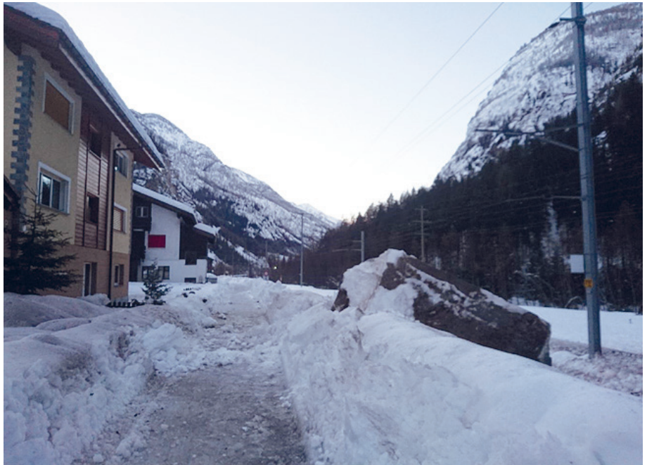
Fig. 143: Le 22 janvier en soirée, un bloc de rocher de 10 tonnes est tombé sur les rails du MBG près de Mattsand (VS) (photo: W. Gitz, 23.01.2018).
