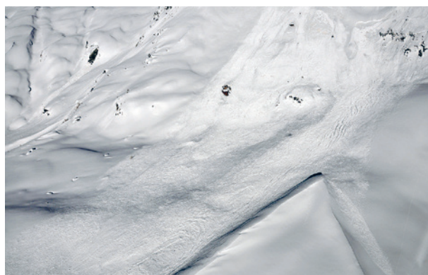
Fig. 129: Le dépôt de l'avalanche a pratiquement atteint la crête de la digue de déviation Ritzmad, d'une hauteur de 10 m. Il n'y a pas eu de déversement sur la digue. Les accumulations de neige soufflée ont fortement chargé le côté est de la digue (photo: SLF/S. Margreth, 24.01.2018).
