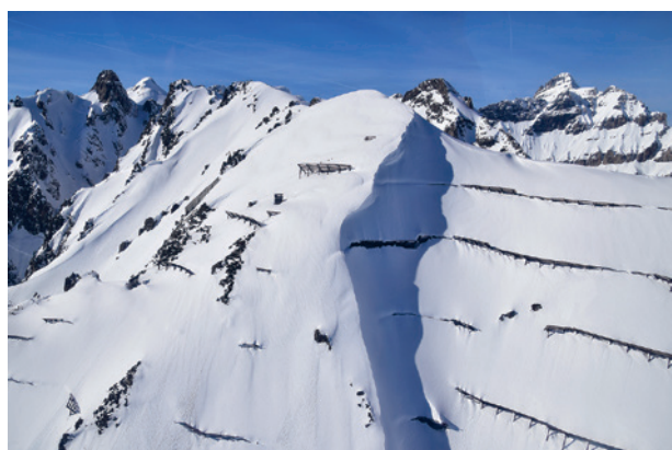
Fig. 108: Ouvrage de retenue de La Rebarme dans le Bas-Valais. Dans la partie centrale de l'image, les ouvrages de retenue présentent une hauteur de 6 mètres. La hauteur de neige a dû s'élever le 24 janvier 2018 localement à plus de 8 m (photo: J.L. Lugon).
