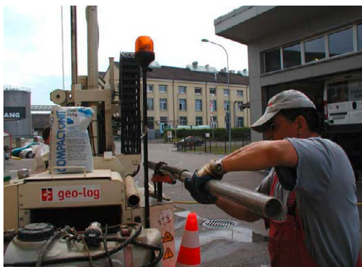
Figure 17 : Un technicien retire un liner en plastique d'une tige de forage
