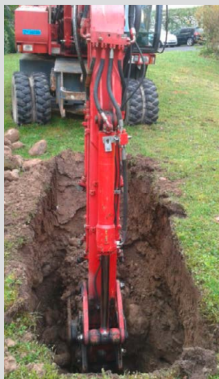
Figure 13 : Sondage à la pelle mécanique
