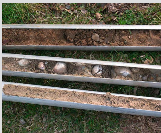
Figure 14 : Tiges de forage contenant des matériaux prélevés dans le cadre d'un forage carotté battu
