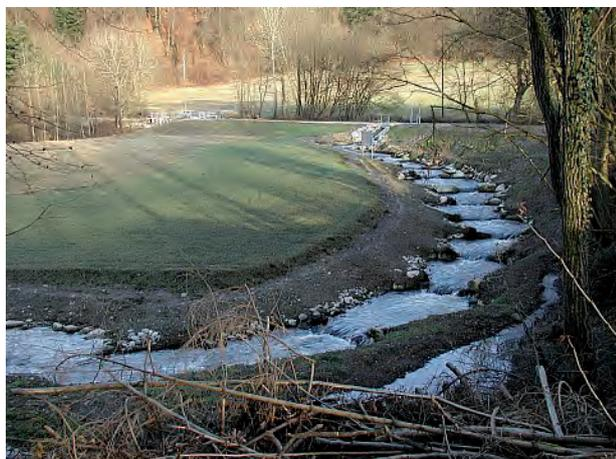
Les barrages et autres ouvrages transversaux de grande hauteur peuvent être rendus franchissables pour la faune aquatique par la création d'un ruisseau de contournement naturel. L'un des grands avantages des ruisseaux de contournement est qu'ils permettent simultanément de mettre à la disposition de diverses espèces de poissons et de leurs différents stades de développement des habitats de substitution, y compris des habitats de reproduction.
