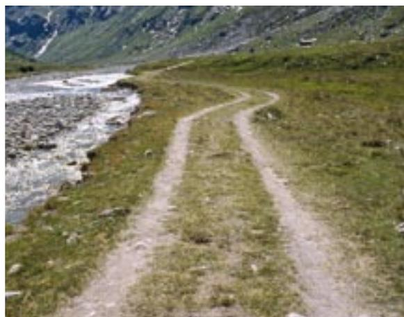
Le chemin d'accès est menacé par l'érosion et, le cas échéant, devra être reconstruit en dehors de la zone dynamique du cours d'eau; Lampertschalp, n° 1323 GR (Photo: Service conseil Zones alluviales)
