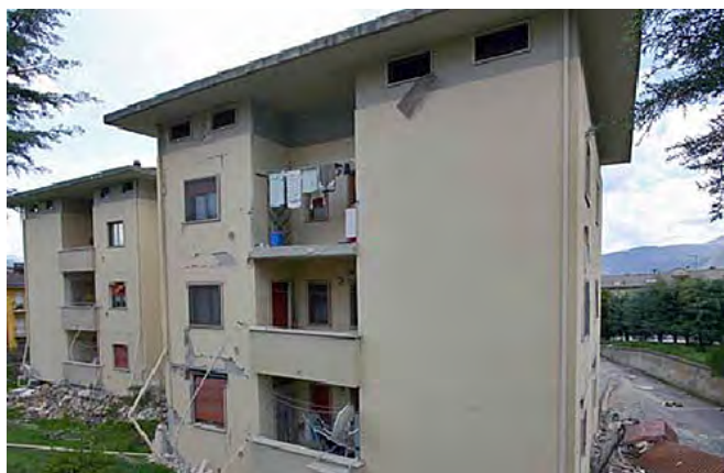
Fig. 2.6.3 > Chute du parapet de l'étage supérieur
