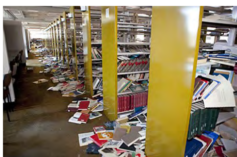
Fig. 2.22.5 et 2.22.6 > Renversement de plusieurs rangées d'étagères par effet domino
