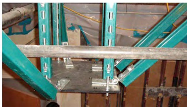
Fig. 2.15.4 > Contreventement de luminaires lourds
