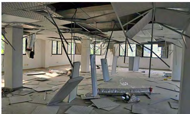
Fig. 2.15.1 et 2.15.2 > Chute d'éléments d'éclairage
