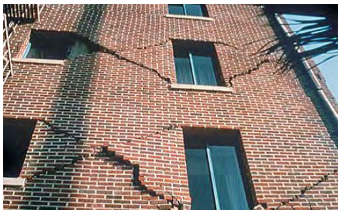
Fig. 2.5.1 > Fissures en croix entre fenêtres
