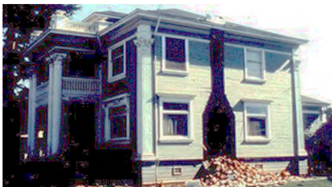
Fig. 2.10.1 > Effondrement d'une cheminée
