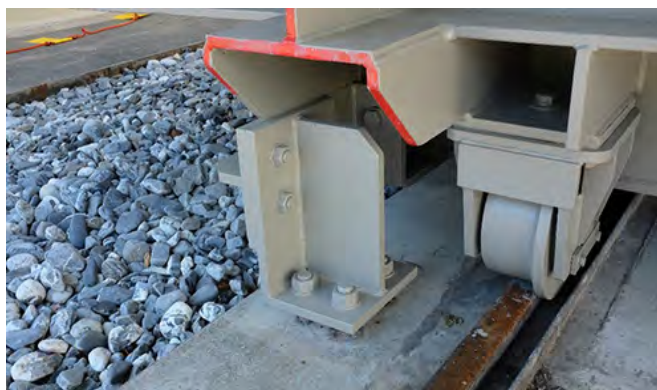
Fig. 2.14.3 > Fixation d'un transformateur monté sur roues
