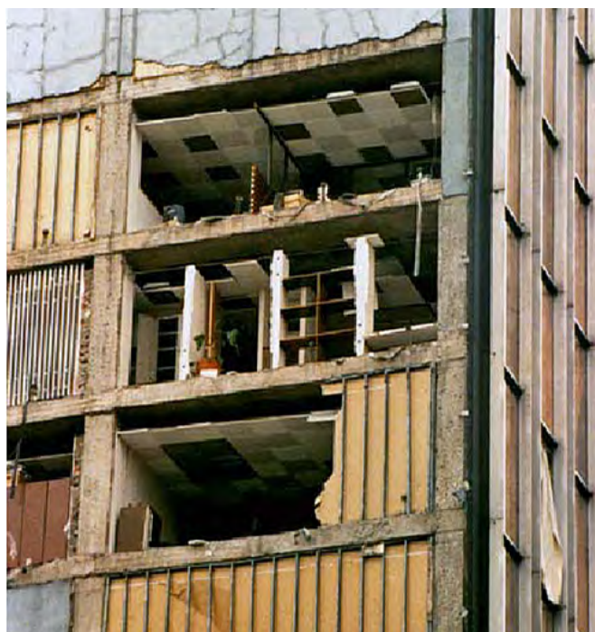
Fig. 2.5.3 > Rupture d'une façade suspendue
