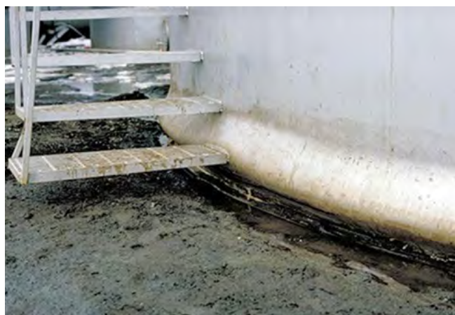
Fig. 2.17.4 > Voilement de la paroi d'une citerne (« pied d'éléphant »)
