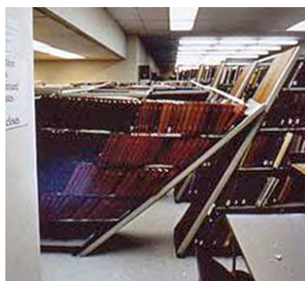
Fig. 2.22.1 et 2.22.2 > Mécanisme de ruine dans le plan («in plane») pour des étagères
