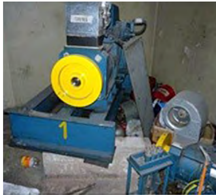
Fig. 2.19.2 > Unité d'entraînement mal fixée
