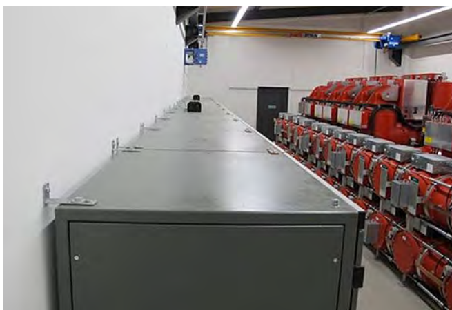
Fig. 2.13.6 et 2.13.7 > Sécurisation de coffrets ou d'armoires contre une paroi
