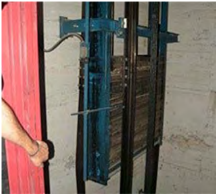
Fig. 2.19.1 > Rails de guidage déformés par des contrepoids
