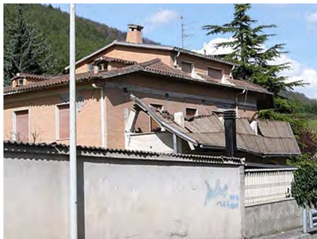
Fig. 2.9.2 > Avant-toit effondré
