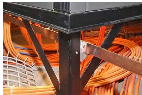
Fig. 2.3.8 > Stabilisation horizontale par barres diagonales
