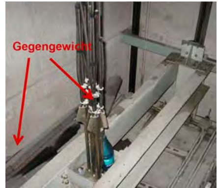
Fig. 2.19.3 > Chute de contrepoids et dégâts aux poutres transversales
