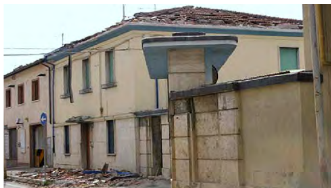
Fig. 2.10.2 > Tuiles tombées à terre
