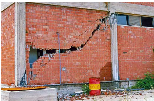
Fig. 2.4.1 > Rupture d'une diagonale sollicitée en compression dans la maçonnerie et endommagement des colonnes en béton armé
