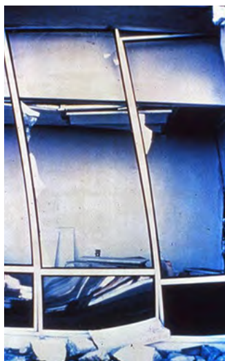
Fig. 2.8.2 > Cadres de fenêtres cintrés dans un bâtiment flexible
