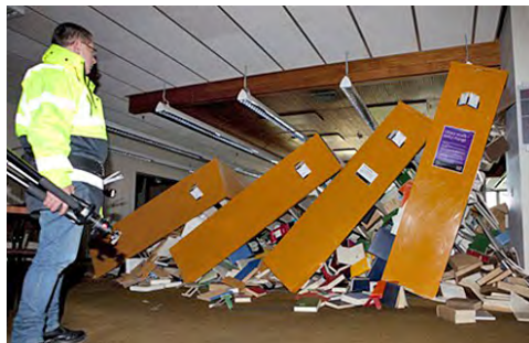
Fig. 2.22.5 et 2.22.6 > Renversement de plusieurs rangées d'étagères par effet domino
