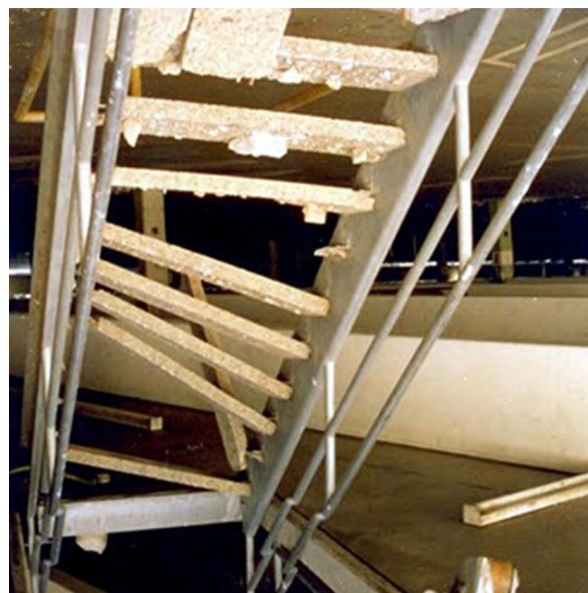
Fig. 2.7.4 > Dislocation de marches d'escalier
