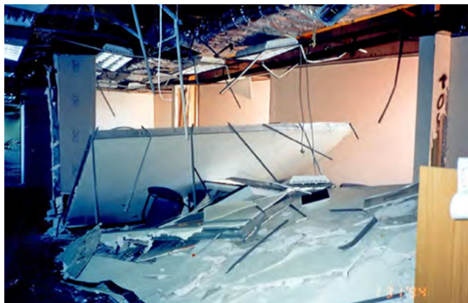
Fig. 2.4.3 et 2.4.4 > Dégâts subis par des parois en construction légère
