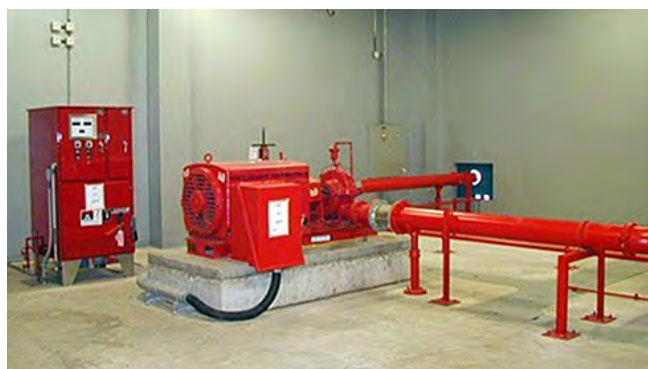
Fig. 2.12.4 > Fixation de la pompe et de l'unité de commande, raccords flexibles et jeu ménagé au passage à travers un mur
