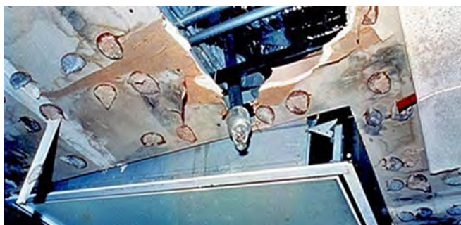
Fig. 2.12.1 et 2.12.2 > Tête de sprinkler endommagée
