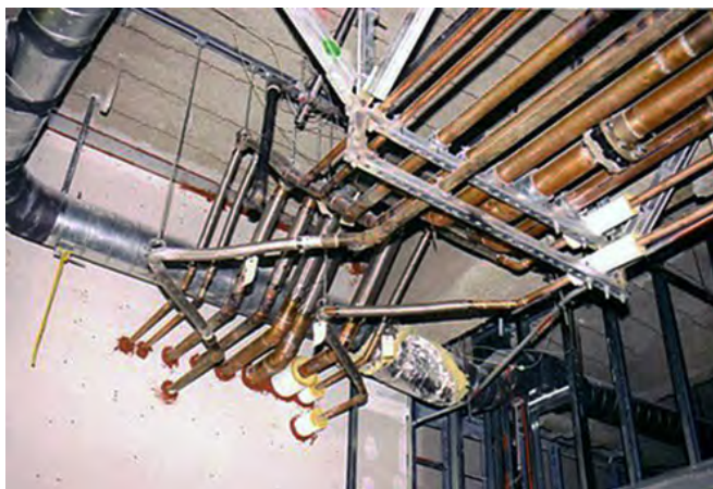
Fig. 2.18.10 > Raccords flexibles au droit de traversées murales, contreventement de voies de conduites
