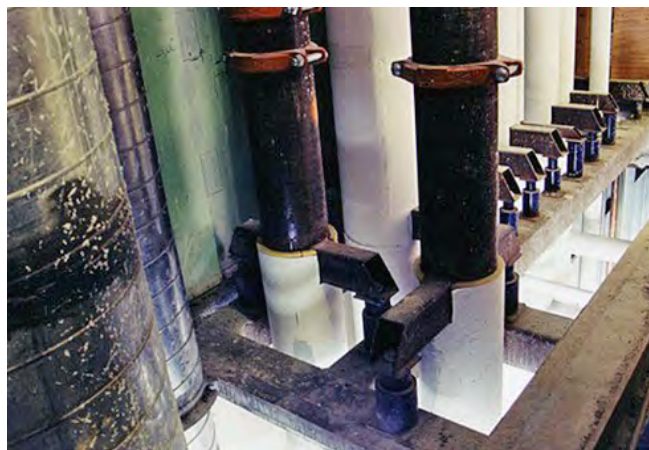
Fig. 2.18.11 > Appui de conduites verticales au passage de dalles
