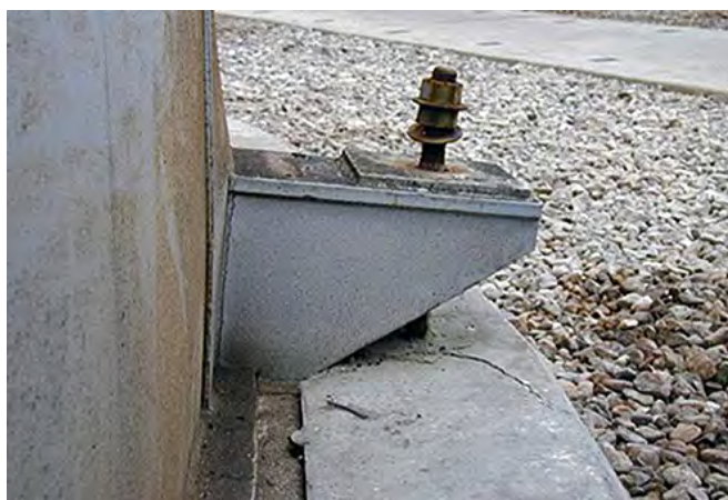
Fig. 2.17.3 > Fixation endommagée
