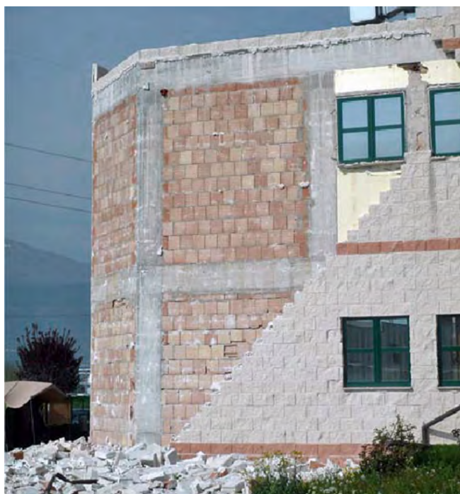
Fig. 2.5.4 > Chute d'une façade en maçonnerie préfabriquée
