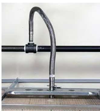
Fig. 2.12.3 > Raccord flexible à une conduite principale
