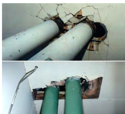
Fig. 2.18.6/2.18.7 > Dommages à des passages à travers des murs
