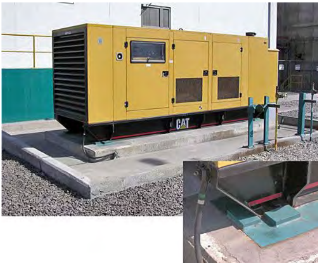
Fig. 2.16.7 > Butée horizontale bloquant un générateur
