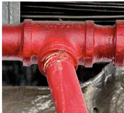
Fig. 2.18.3 > Dégâts à un embranchement
