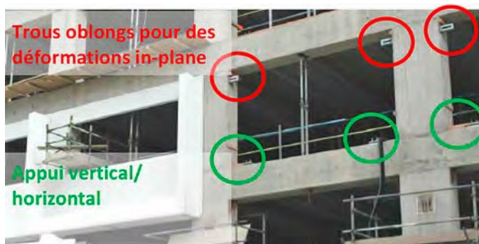
Fig. 2.5.5 > Consolidation d'éléments de façade par des trous oblongs
