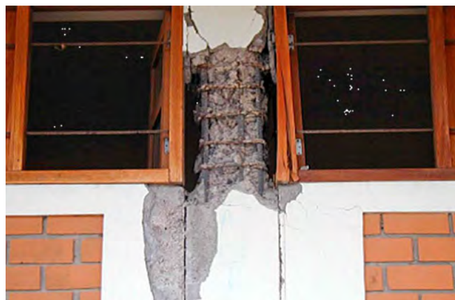
Fig. 2.4.2 > Rupture par cisaillement dans un poteau court en présence d'un remplissage en maçonnerie
