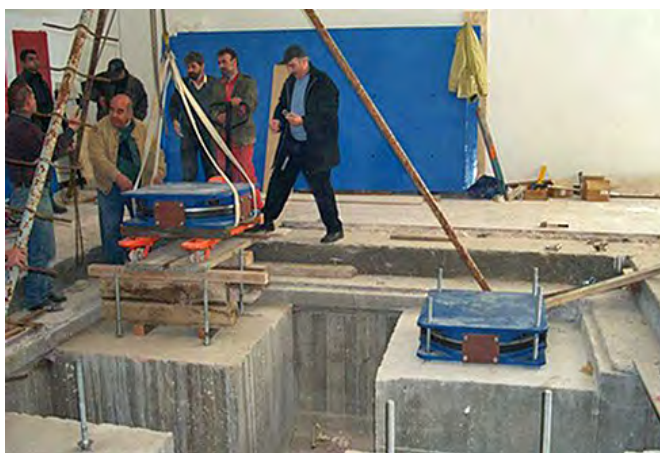
Fig. 2.25.6 et 2.25.7 > Fondation isolée contre les vibrations destinée à une sculpture
