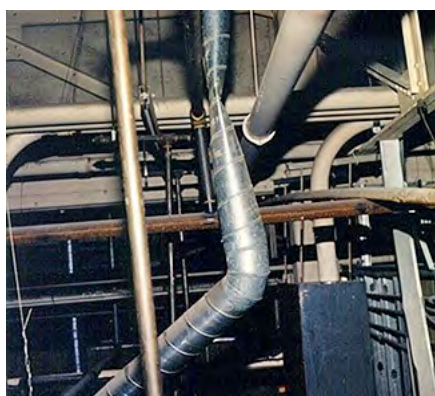
Fig. 2.18.1 > Dégâts dus à des chocs
