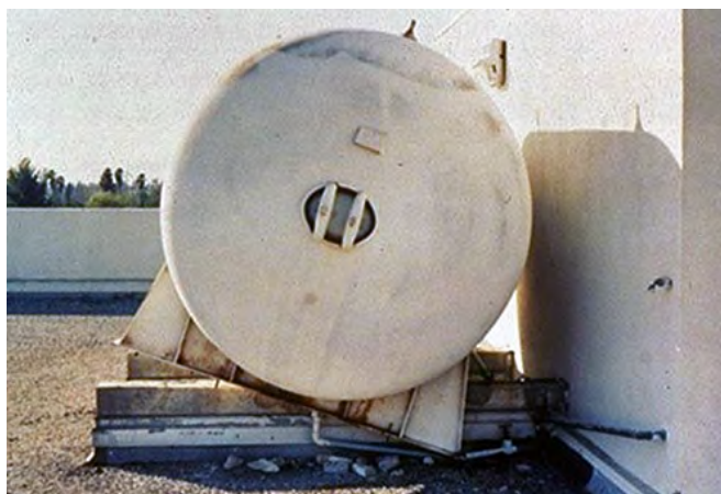
Fig. 2.17.1 et 2.17.2 > Effet des forces d'inertie sur des citernes
