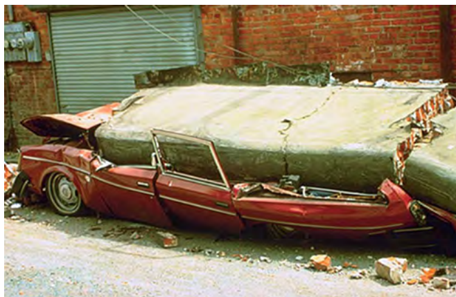
Fig. 2.6.1 et 2.6.2 > Effondrement sous l'effet de forces d'inertie transversales au plan du parapet
