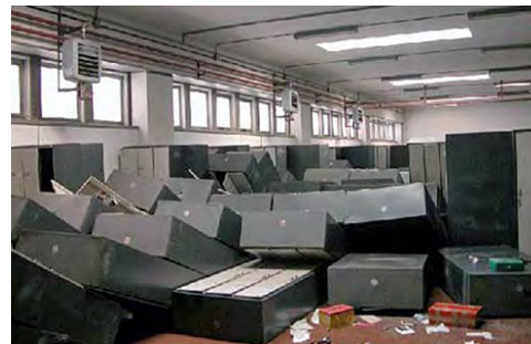
Fig. 2.22.5 et 2.22.6 > Renversement de plusieurs rangées d'étagères par effet domino
