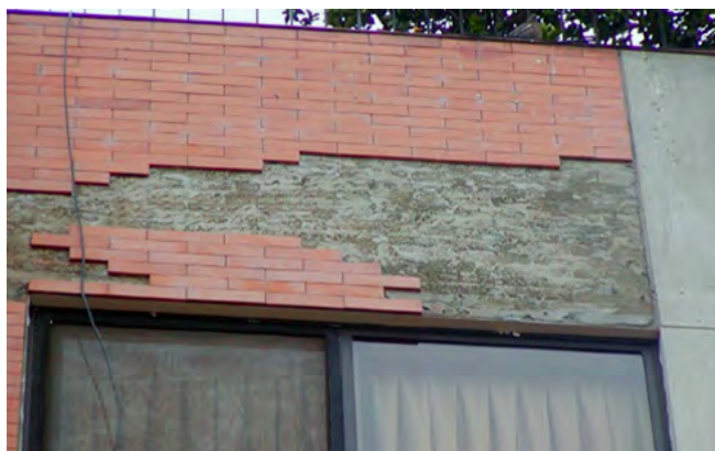
Fig. 2.5.2 > Décollement d'éléments
