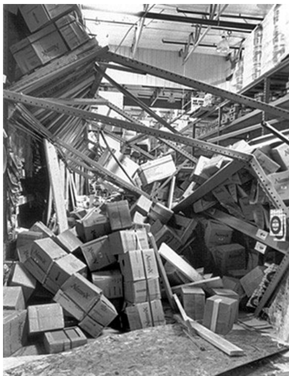
Fig. 2.23.1, 2.23.2 et 2.23.3 > Effondrement d'un entrepôt d'étagères
