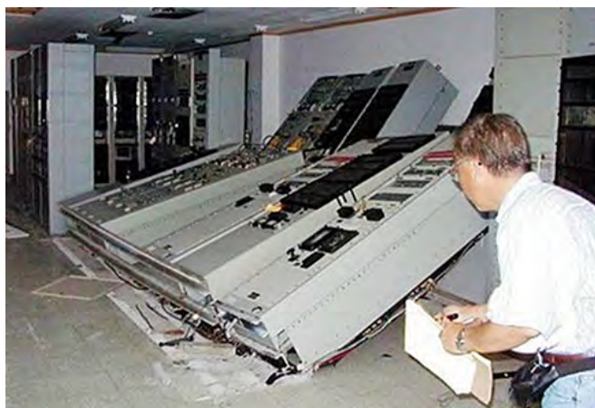
Fig. 2.13.1 et 2.13.2 > Armoires de commande renversés
