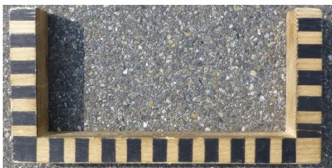
Mörschwil, Rorschacherstrasse, MoaMikro5, 2016
