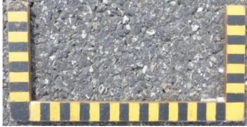
Seengen, Brestenbergstrasse ACMR 8 2012
