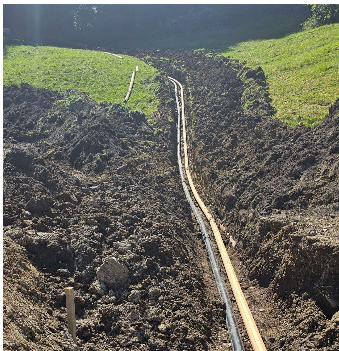
Abbildung 2: Beim Grabenaushub ist die Vegetation in Soden sorgfältig abzutragen und am Schluss wieder einzubringen. Auch der Boden ist gemäss Ausgangszustand wieder einzuschichten. (Foto: Kellerhals + Häfeli AG)
