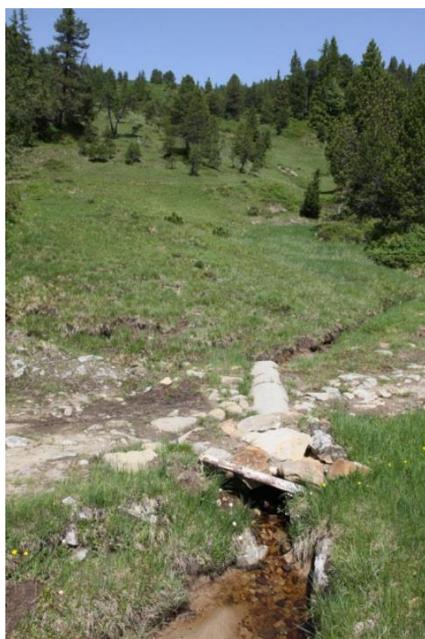
Abbildung 1: Ein kleiner Graben entlang des Wanderweges führt das Wasser in einen Durchlass unter den Weg hindurch. Unterhalb des Weges führt dies zu starker Erosion und es bilden sich bis zu zwei Meter tiefe Gräben. Diese wirken wie Drainagen und trocknen das weiter unten liegende Flachmoor völlig aus. (Fotos: LIN'eco)
