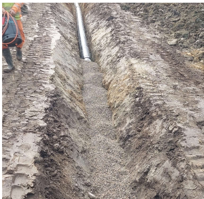
Abbildung 1: Kies- und Sandeinfüllungen in Leitungsgräben können je nach Lage drainierend wirken. (Foto: Kellerhals + Häfeli AG)
