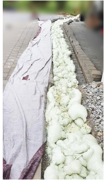
fertiger Injektionskörper (ohne Abschlussarbeiten)
