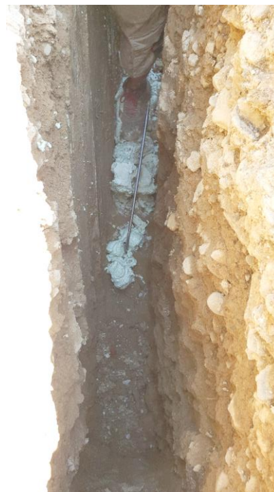
Boden nach 1. Injektion
