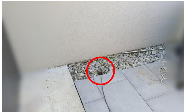
Messpunkt MP4, neben dem Gebäude Nordseite
