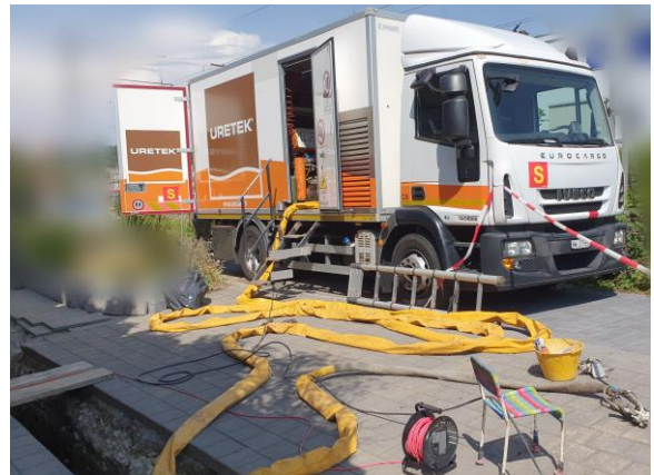
Baufahrzeug Uretek mit Injektionsausrüstung
