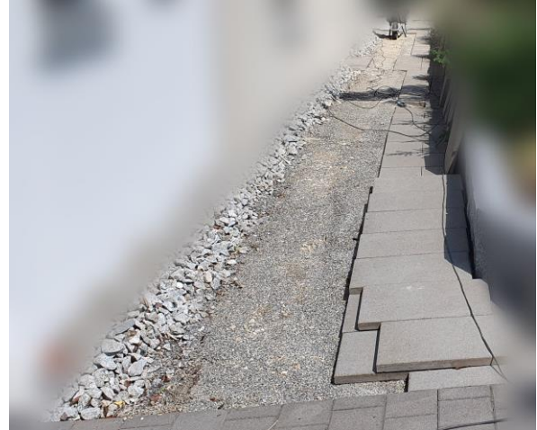
Zustand bei Messung Vorher
