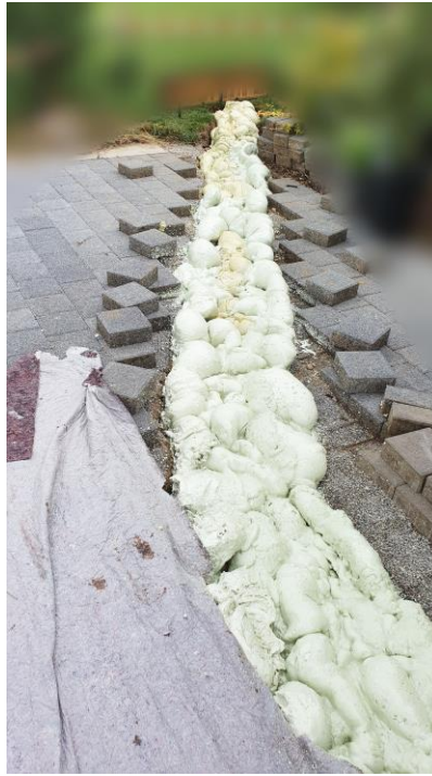
fertiger Injektionskörper (ohne Abschlussarbeiten)
