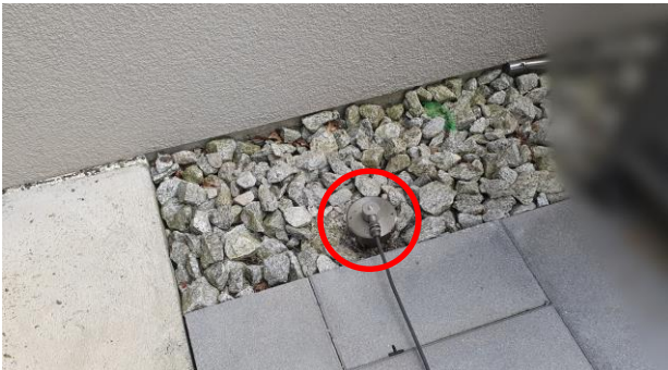
Messpunkt MP4, neben dem Gebäude Nordseite
