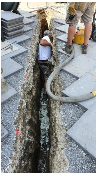
Injektionsarbeiten für 1. Bohrreihe
