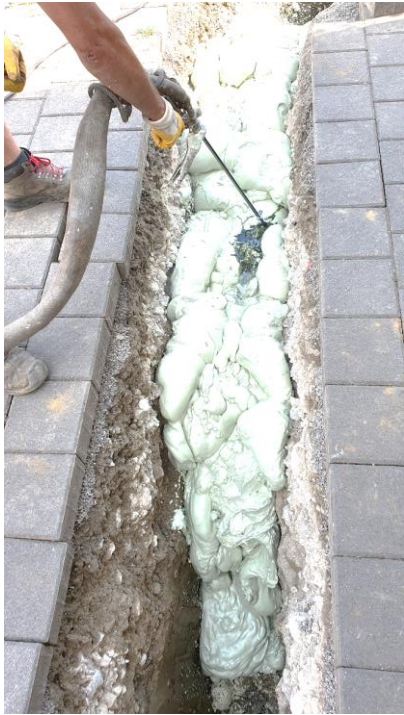
Ausschäumen des offenen Bodenschlitzes
