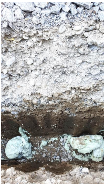
Bodenaufbau im offenen Bodenschlitz
