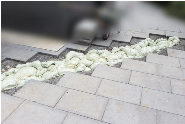
fertiger Injektionskörper (ohne Abschlussarbeiten)
