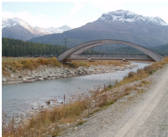
Fig. 84 Immagine per il rilievo di un ponte.
