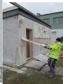
Figura 30 Rimozione manuale di finitura su isolamento esterno di facciata. A sinistra "strippaggio" dell'intonaco con relativa rete.
