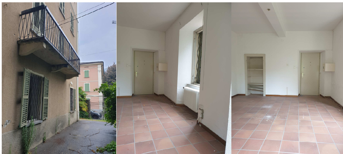
Figura 36 Demolizione Ex Vanoni: Stato di alcuni ambienti interni e delle facciate al momento della demolizione distruttiva.
