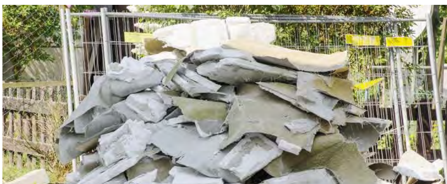
Raccolta separata del materiale isolante su suolo pavimentato. Su suolo naturale è necessario posare un telo di protezione.
