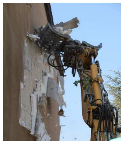
Figura 24 Rimozione di un isolamento esterno di facciata con metodo parzialmente selettivo. Uso di demolitore selezionatore.
