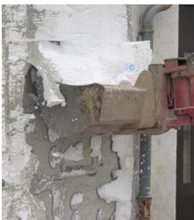
Figura 26 Rimozione strato isolante in pannelli in EPS. Uso di benna prensile meccanica.
