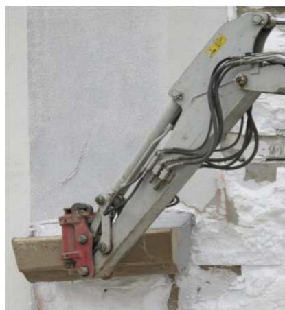
Figura 25 Rimozione strato intonaco di finitura. Strato isolante in pannelli in EPS. Uso di benna prensile meccanica per pelatura a macchina.
