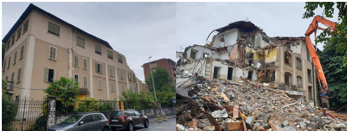
Figura 33 Demolizione dello Stabile Ex Vanoni: facciata fronte strada e situazione verso l'area interna del mappale
