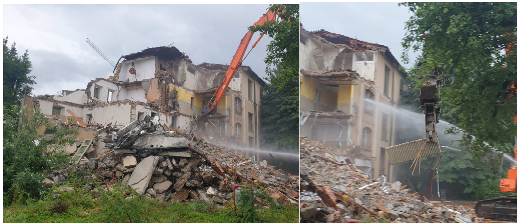
Figura 35 Demolizione Ex Vanoni: a sinistra raccolta di elementi di cemento armato per successiva macinazione e separazione del materiale ferroso, a destra raccolta di un radiatore
