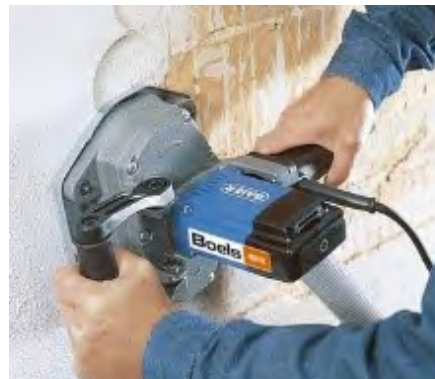
Fresatura con fresatrice a disco
