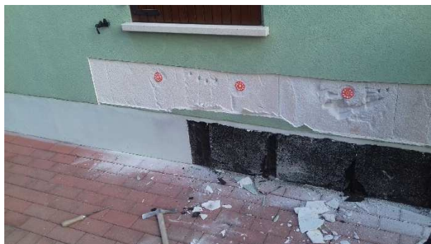
Figura 31 Rimozione manuale dello strato di intonaco. Strato isolante pannelli in EPS. Uso di utensili da taglio, scalpellatura e smerigliatrice (rimozione manuale).
