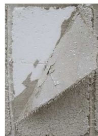
Figura 30 Rimozione manuale di finitura su isolamento esterno di facciata. A sinistra "strippaggio" dell'intonaco con relativa rete.
