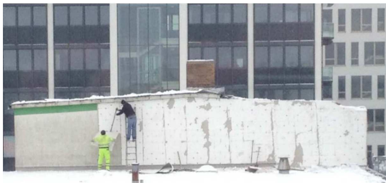
Figura 30 Rimozione manuale di finitura su isolamento esterno di facciata. A sinistra "strippaggio" dell'intonaco con relativa rete.
