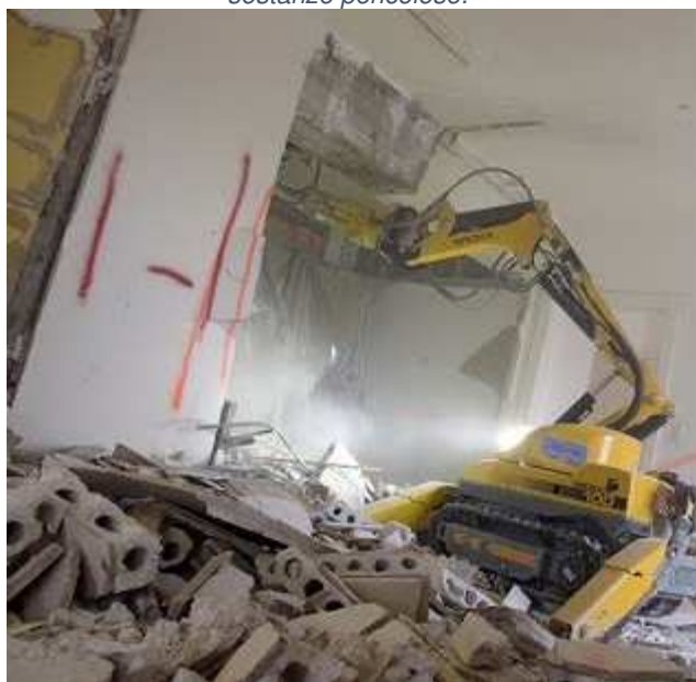
Figura 41 Strip out: demolizione interna con mezzo leggero radiocomandato.
