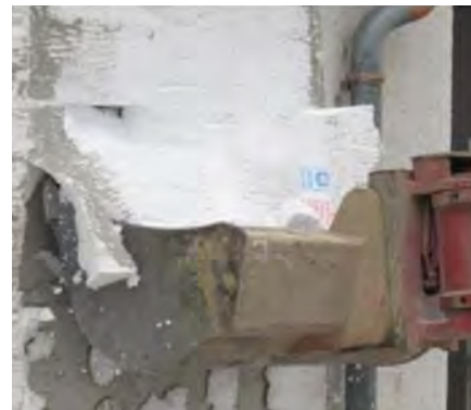
Rimozione meccanica con benna piatta
