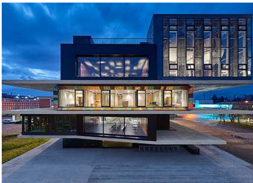
Figura 20 Visione di insieme dell'edificio NEST. Fonte EMPA, empa.ch
