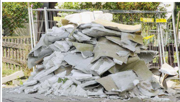
Figura 27 Isolamento esterno di facciata rimosso con metodo parzialmente selettivo.
