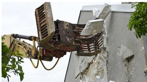
Figura 29 Rimozione di un isolamento esterno di facciata con metodo parzialmente selettivo.
