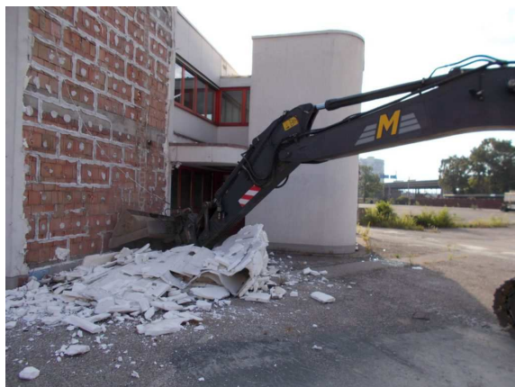
Figura 28 Rimozione di un isolamento esterno di facciata con metodo parzialmente selettivo.
