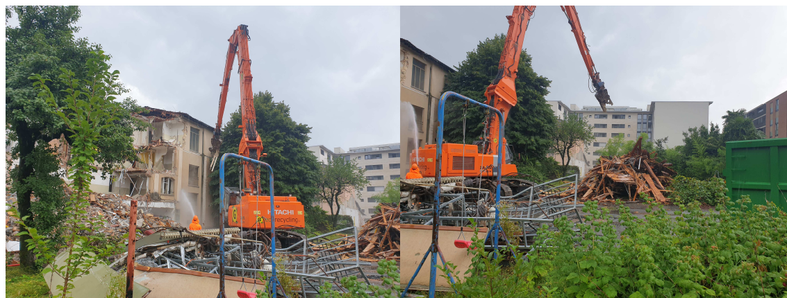
Figura 34 Demolizione ex Vanoni: A sinistra raccolta dei metalli, a destra raccolta dei materiali lignei
