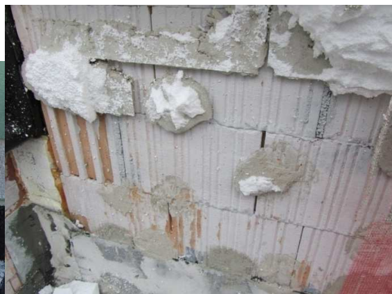
Figura 32 Residui sulla muratura portante dopo l'asportazione di rivestimento con cappotto termico in EPS.
