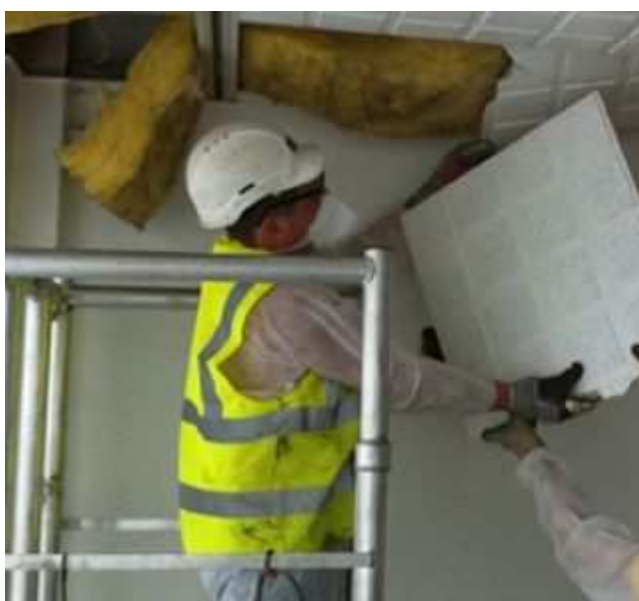
Figura 40 Strip out: rimozione lastre controsoffitto contenente amianto.
