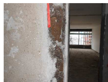
Figura 14, Nello stesso edificio è stato rilevato: a) strato isolante termico a base di sughero costituente il nucleo della doppia muratura in calcestruzzo delle pareti perimetrali. Tale strato è incollato con un adesivo bituminoso; b) strato isolante termico a base di sughero che riveste esternamente le pareti dei vani degli ascensori, incollato invece con malta cementizia. (@imc_7400).
