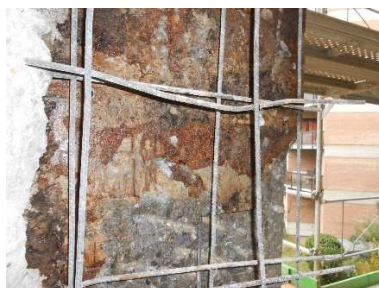
Figura 14, Nello stesso edificio è stato rilevato: a) strato isolante termico a base di sughero costituente il nucleo della doppia muratura in calcestruzzo delle pareti perimetrali. Tale strato è incollato con un adesivo bituminoso; b) strato isolante termico a base di sughero che riveste esternamente le pareti dei vani degli ascensori, incollato invece con malta cementizia. (@imc_7400).
