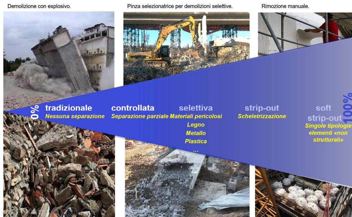
Figura 37 Livelli crescenti di separazione consentono livelli crescenti di riciclo/riuso dei rifiuti da costruzione e demolizione (C&DW).
