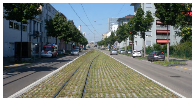
Fig. 38: Horburgstrasse a Basilea – linea traviaria prima e dopo il rinverdimento
