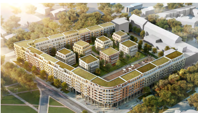
Fig. 75: Superfici dei tetti nel quartiere Goethe di Offenbach
