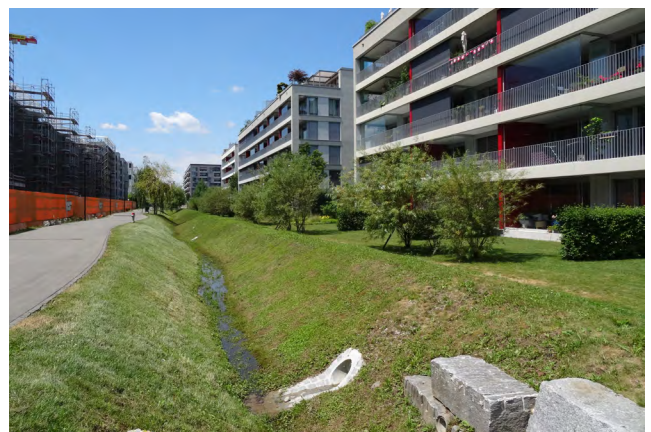
Fig. 57: I fossi convogliano l'acqua piovana degli edifici verso il laghetto nell'Opfikerpark.
