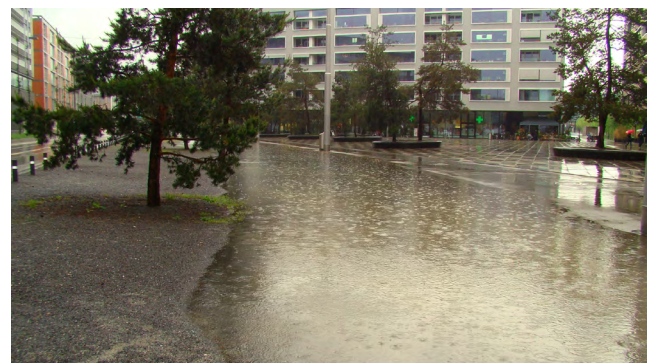
Fig. 54 e 55: Max-Bill-Platz, prima e dopo la ristrutturazione
