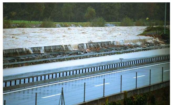
Fig. 92: Tratto allagabile dell'autostrada A2 tra Attinghausen e Seedorf (UR) durante la piena dell'ottobre 2020
