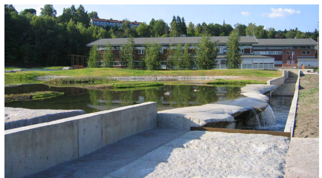
Fig. 45: Stagno naturale balneabile con ritenzione e sfioratore
