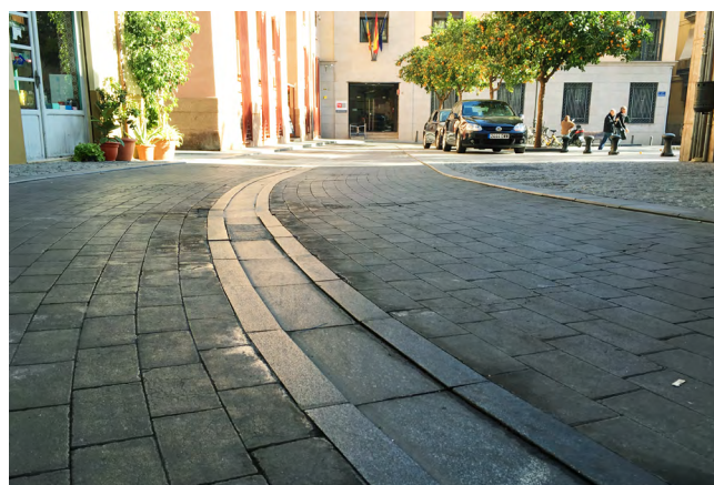
Fig. 89: Centro storico di Valencia con cunette filtranti di smaltimento
