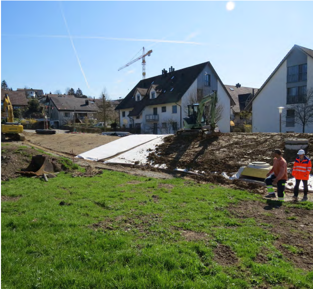
Fig. 24: Argine rialzato con opera di sbocco e sfioratore d'emergenza posto in alto
