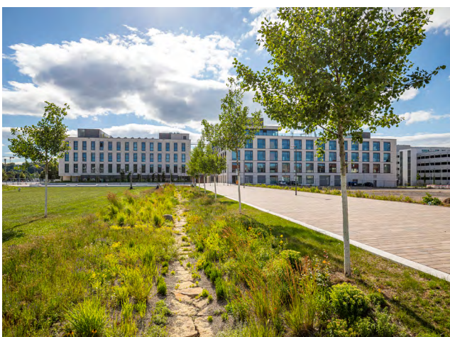
Fig. 78: Un fossato d'infiltrazione filtra l'acqua piovana prima che confluisca nella cisterna
