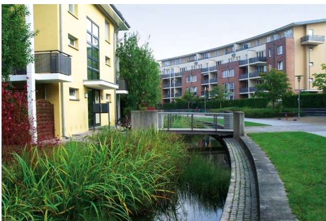
Fig. 56: Parco residenziale Trabrennbahn Farmsen con canale dell'acqua piovana
