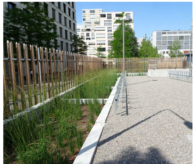
Fig. 59: Fossi scoperti per l'evaporazione e l'infiltrazione
