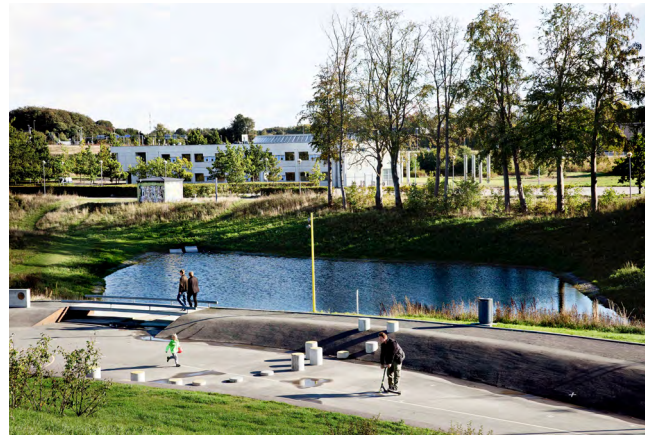
Fig. 86: Bacino di ritenzione sotto forma di laghetto naturale
