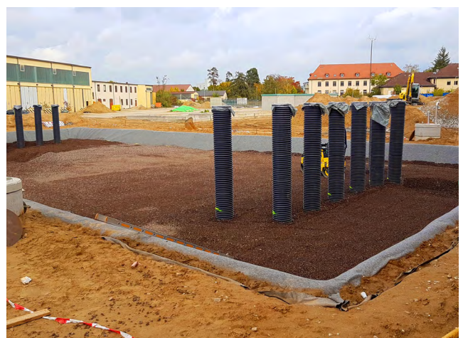
Fig. 67: Gli strati più bassi sono costituiti da elementi in plastica (utilizzo dell'acqua antincendio), mentre l'ulteriore riempimento è costituito da lava (elevato volume dei pori)
