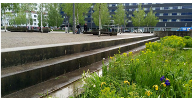
Fig. 53: Turbinenplatz, in caso di precipitazioni persistenti i fossati piantumati raccolgono l'acqua
