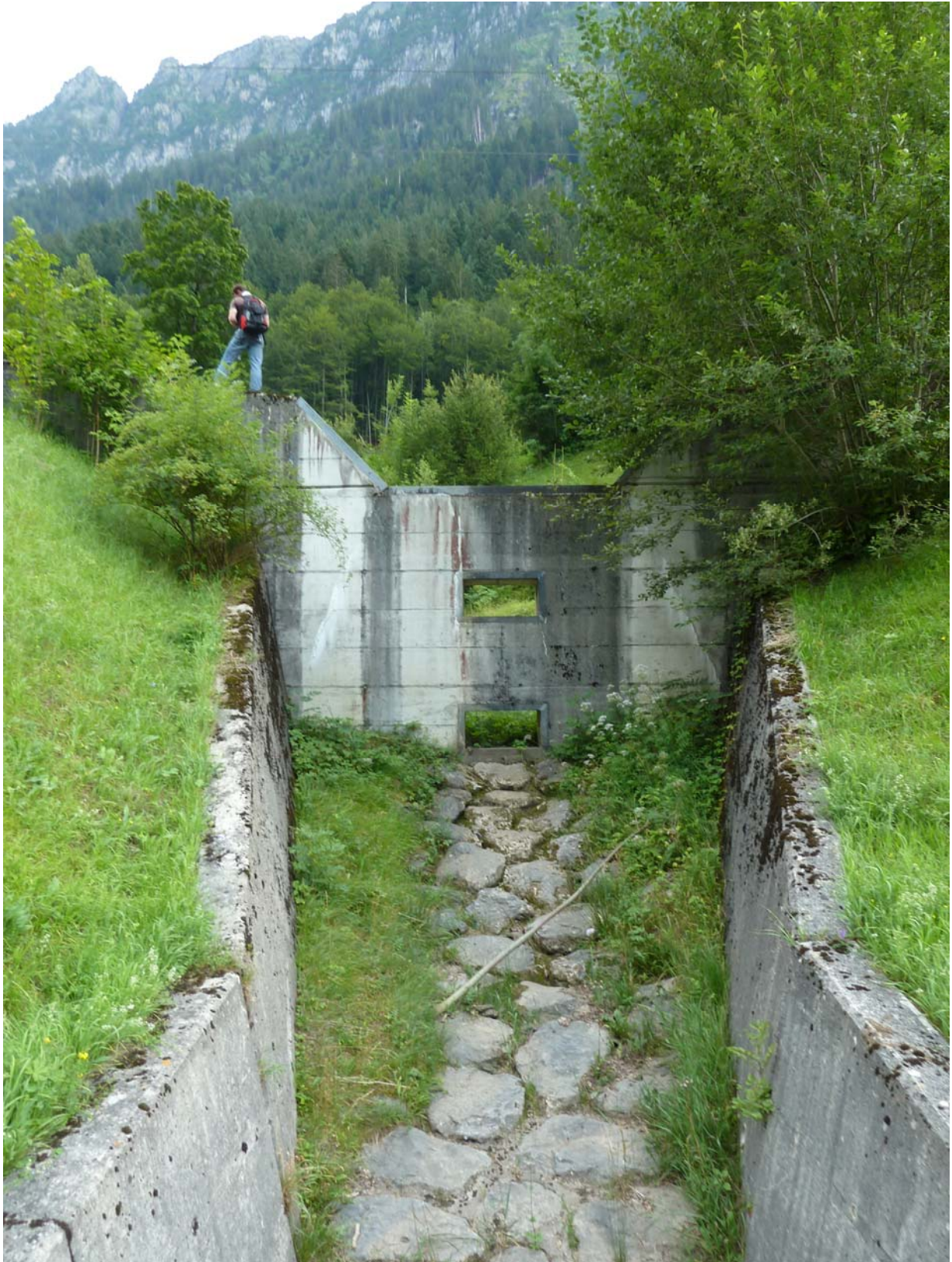
Abbildung 10: Aufnahme Geschiebesammler im inneren Blindlouigraben
