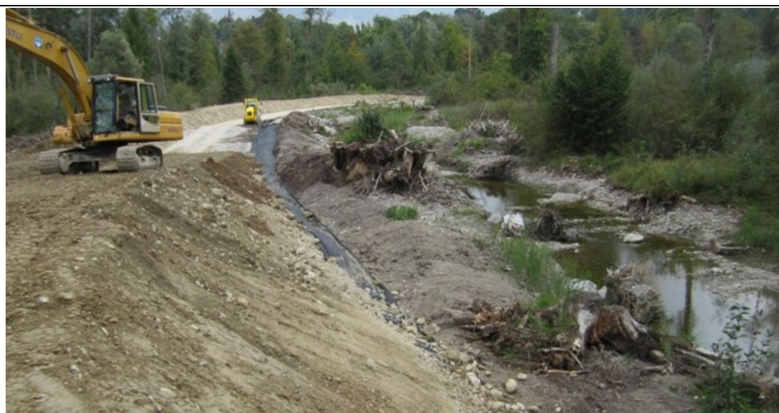
Costruzione dell'argine tra l'Aare (a sinistra) e la Giesse (a destra); vista verso monte.
