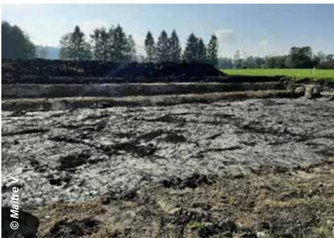
**Abb. 29:** Wiederherstellung eines vollständigen Bodens mit Wiederaufbringen des Torfs auf die Oberfläche (während der Arbeiten). Der Torf wurde abgetragen (im Vordergrund) und wird beim wiederhergestellten Boden als Oberboden-Horizont verwendet. Im Hintergrund sieht man ein längliches Torfdepot.
