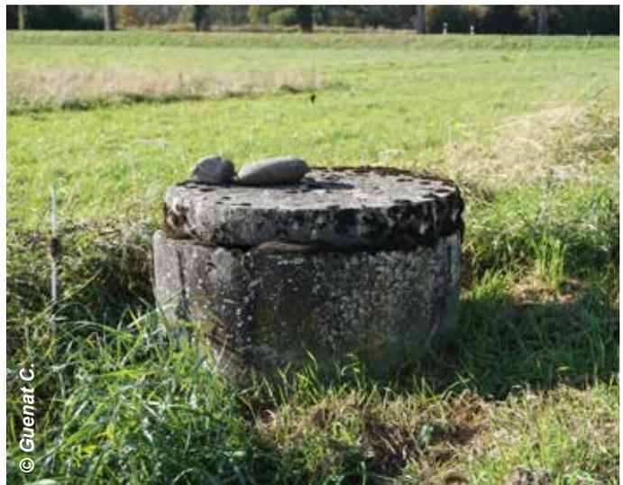
Abb. 19: Über dem Boden liegender Drainage-Schacht.
