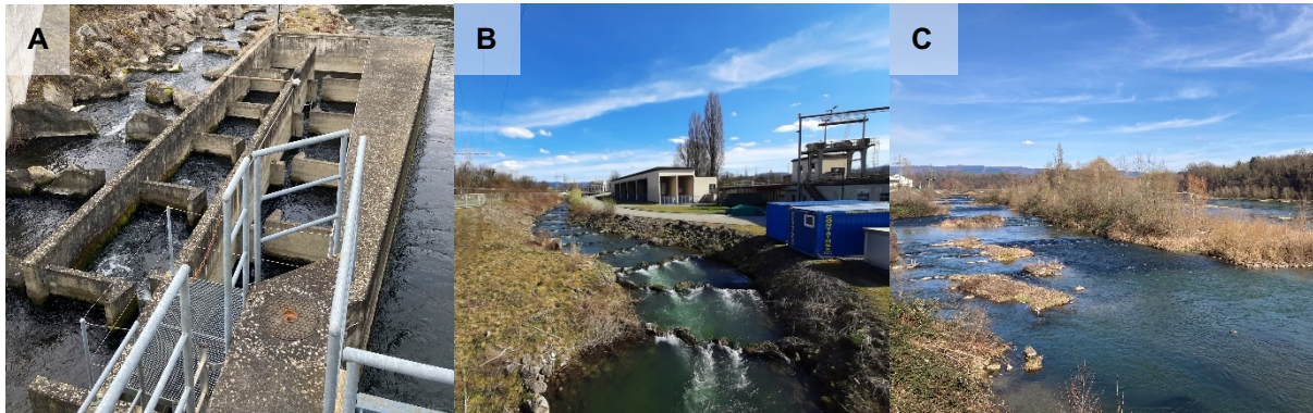
Abbildung 2: Fischaufstiegshilfen-Typen: A) Schlitzpass am Kraftwerk Schiffmühle an der Limmat; B) Raugerinne-Beckenpass am Kraftwerk Ryburg-Schwörstadt am Rhein; C) Umgehungsgewässer am Kraftwerk Rheinfelden am Rhein.
