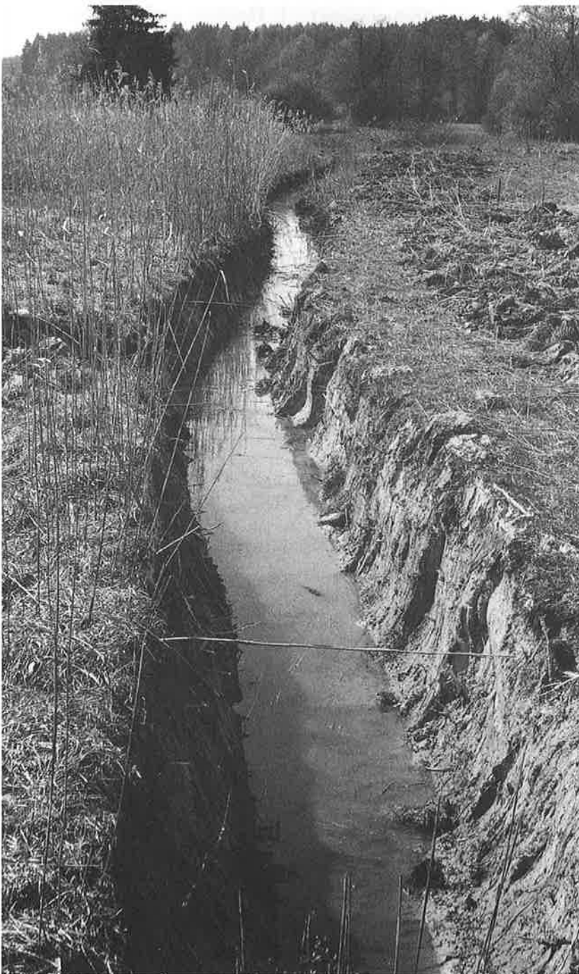
Abb. 5: Maschinell gereinigter Abzugsgraben in einem Flachmoor mit sehr dünner Torfschicht. Der Graben ist zu stark in den mineralischen Untergrund (Seebodenlehm) eingetieft.
