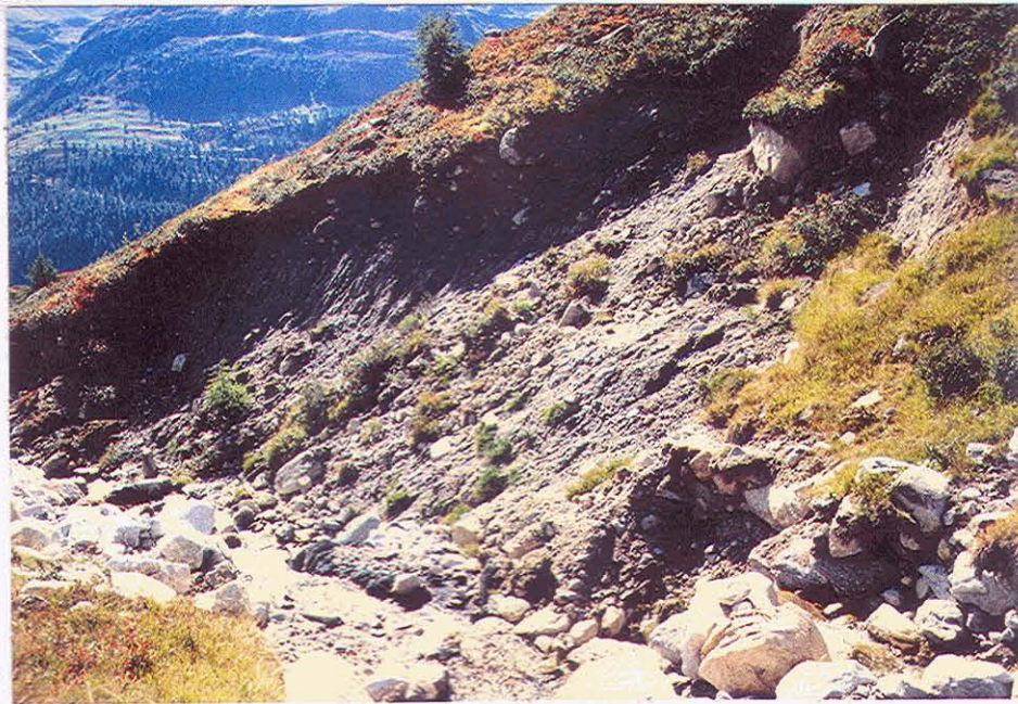
Abb. 7 Uferanbruch im Ri di Cavanna, Ereignis 1987
