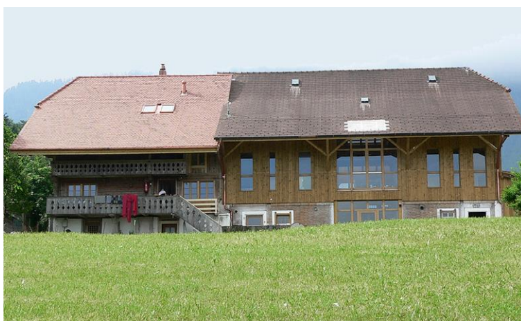
Fig. 28 > Nel caso di cambiamenti di destinazione, ad es. la ristrutturazione di un fienile a scopi abitativi, occorre adempiere condizioni più restrittive del diritto della pianificazione del territorio
