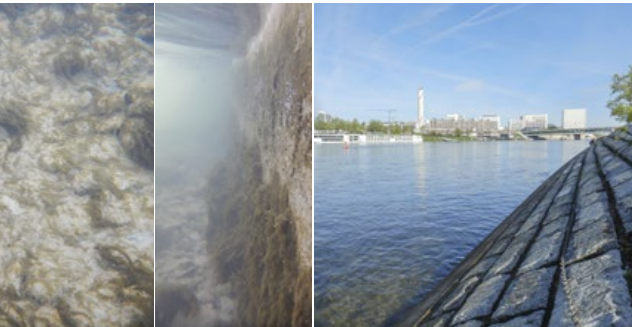
5 Rechtes Ufer: Fester Verbau durch Mauer mit senkrechter Betonkannte zur stark veralgten, steinigen Sohle.
