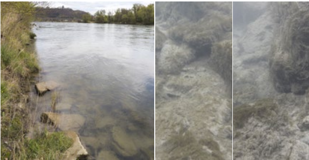
1 Linkes Ufer: Uferbefestigung mit Blöcken am Aareufer in Felsenau.
