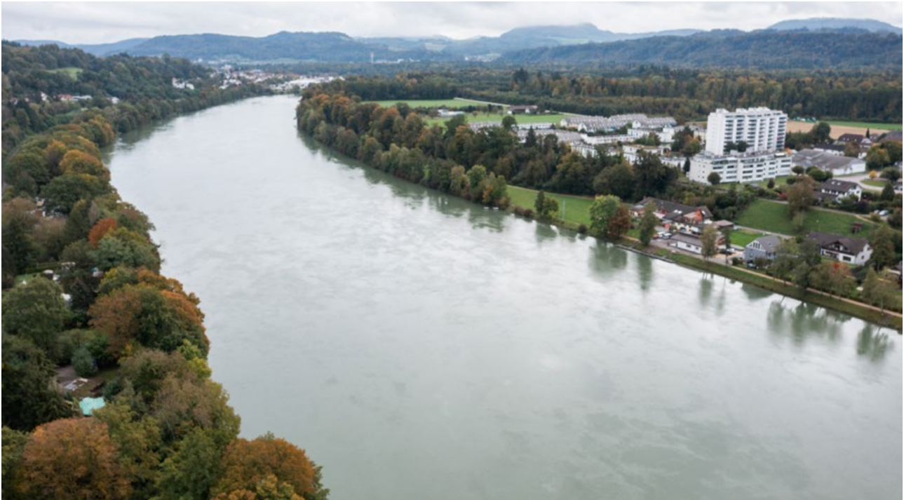
Hochrhein bei Sisseln flussaufwärts betrachtet mit Blick auf den Pontonierverein Sisseln.
