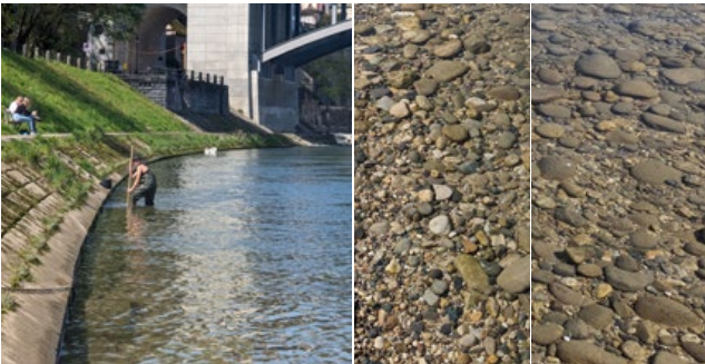
1 Linkes Ufer: Fester Verbau durch Mauer mit senkrechter Betonkannte. Steinige Sohle an Prallhang umgelagert und kaum mit Algen.
