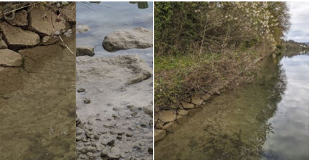
5 Rechtes Ufer: Bis in ca. 30cm Tiefe locker gemauerter Verbau, daran anschliessend Steine mit Sand.
