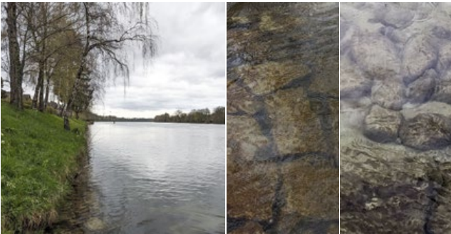
1 Linkes Ufer: Bis auf ca. 0,5m Tiefe mit lockerer Mauer befestigt, darunter vor allem grössere Steine bis Blöcke.
