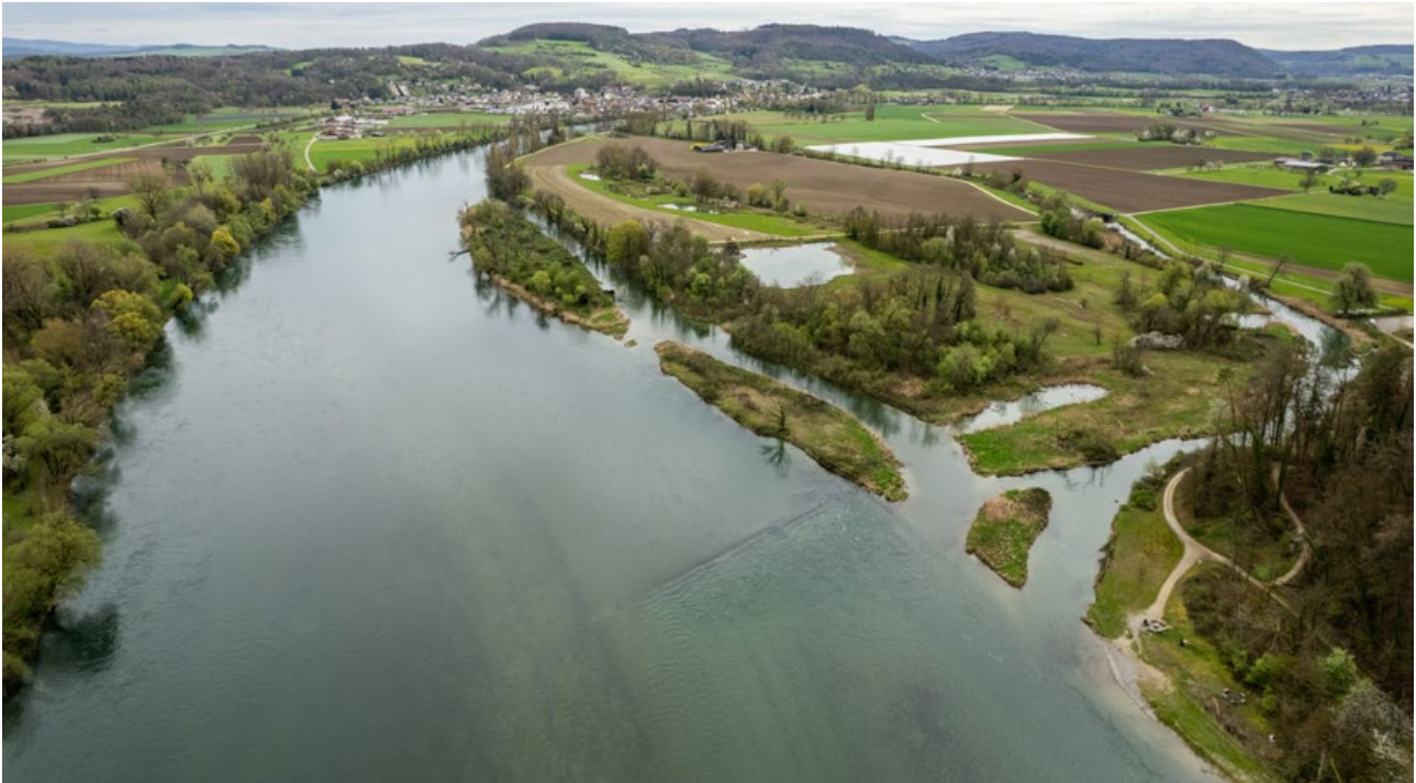
Hochrhein bei Rietheim flussaufwärts betrachtet mit wiederhergestellter Aue «Chly Rhy» am linken Ufer.
