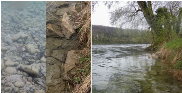
5 Rechtes Ufer: Mit Blöcken befestigt und anfangs steil abfallend. Darauf folgt Kiessohle.
